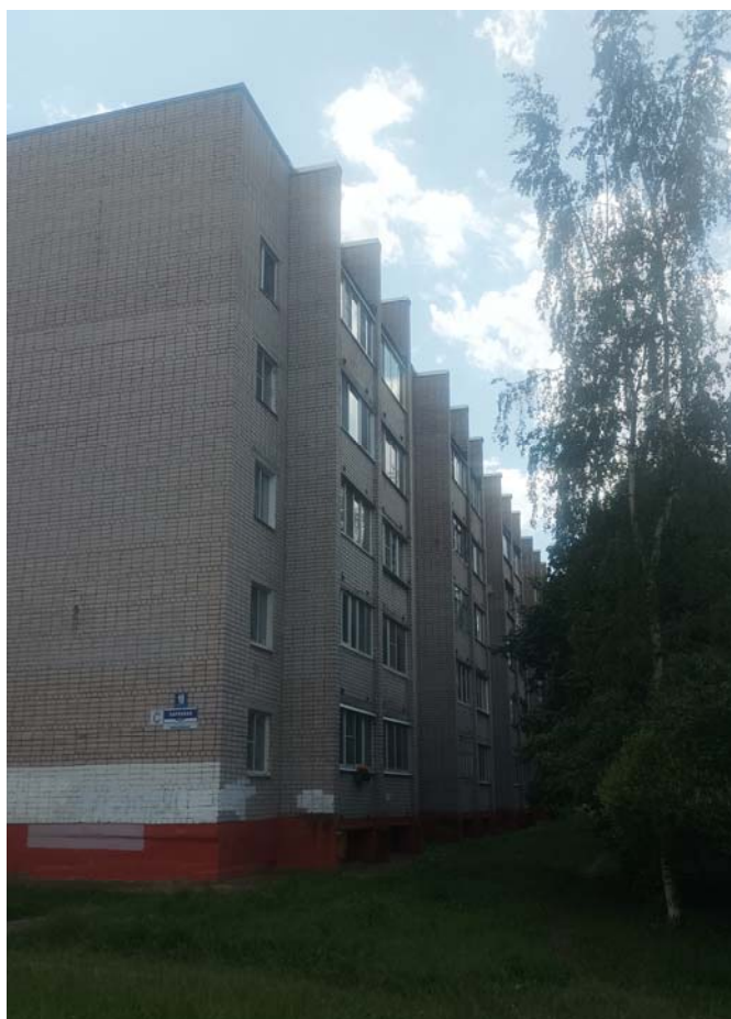
Фото 2. Общий вид на фасад в осях 19-1/Б
