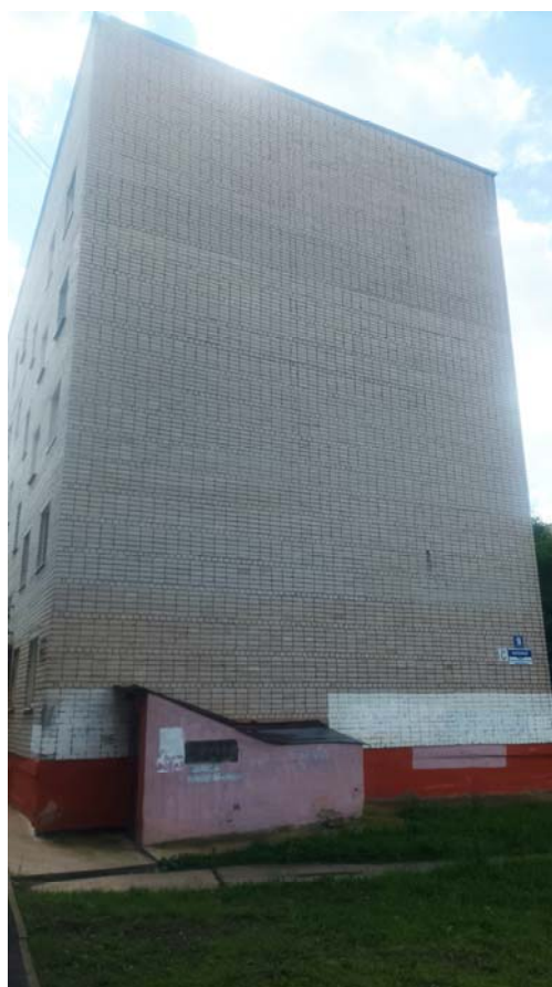
Фото 4. Общий вид на фасад в осях 19/А-Б
