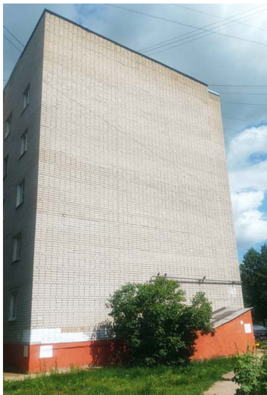
Фото 3. Общий вид на фасад в осях 1/Б-А
