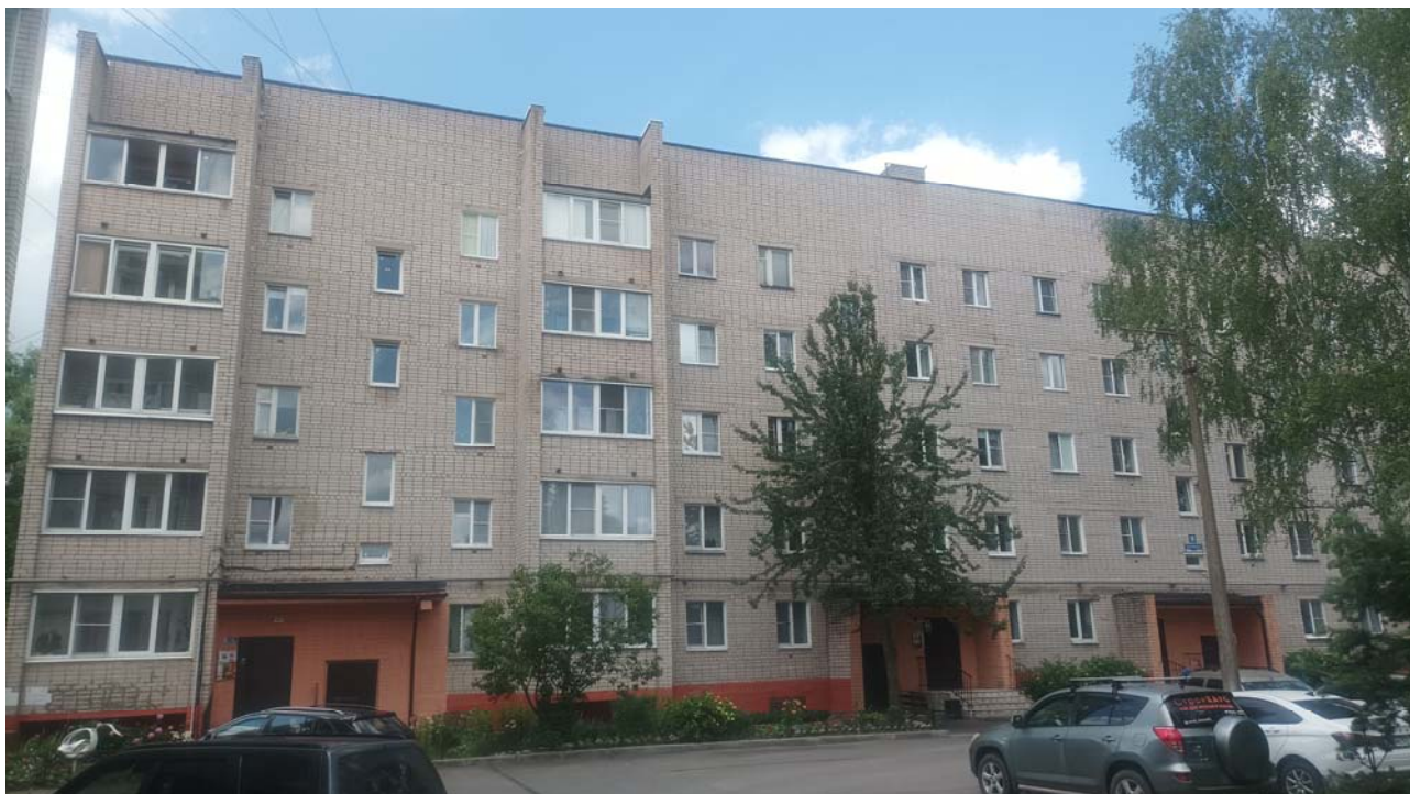
Фото 1. Общий вид на фасад в осях 1-19/А
